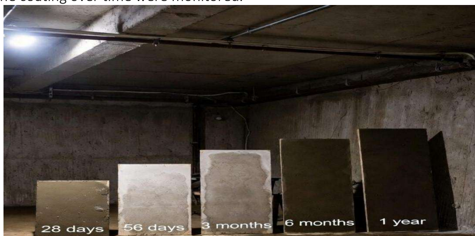
Рисунок 1-Бетонные основания для нанесения штукатурки
